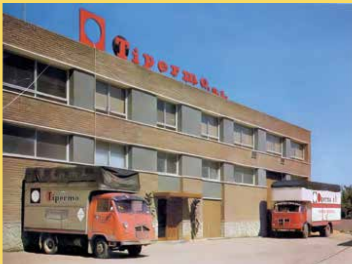
Entrada a la fàbrica.
