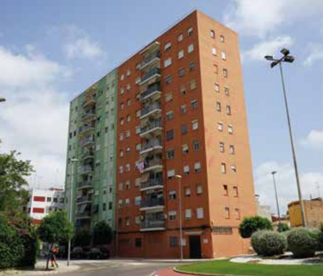
Els locals de la parròquia de la Sagrada Família estaven ubicats en els baixos de l'edifici de la imatge, en l'Avigunda Padre Pompilio, en front de l'actual temple del carrer Trafalgar, 48.
