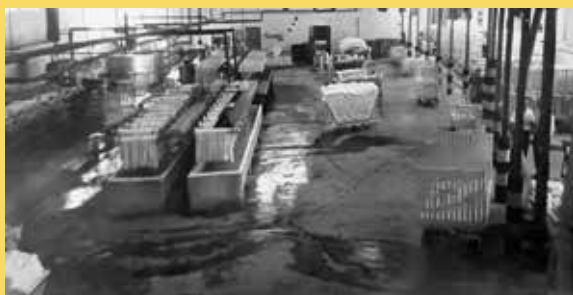
Interior de la fàbrica Tintes El Jucar, als anys 1960. En aquell moment se fabricaven bobines, conos i madeixes i encara no se tintava la tela abans de teixir. Ara se tinta la tela ja teixida. Imatges cedides per Ernest Gonzàlvez Parra, fill de José Gonzàlvez.
